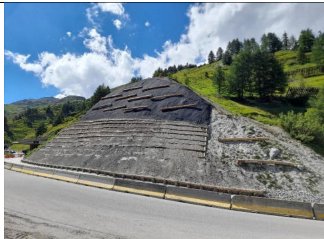
RD87A - Stabilisation du terrain par la méthode Gratta Viva
