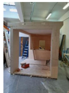
Construction de la guérite
