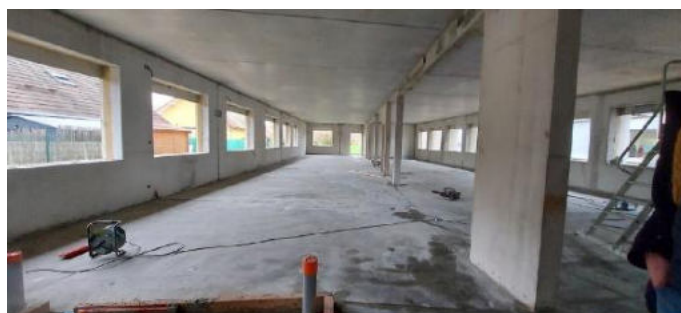
Construction de la Maison techniques de Yenne
