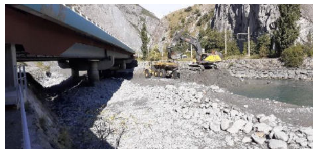
Chantier de curage de l'Arc à Saint Michel de Maurienne
