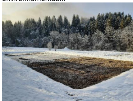
Visite de la station d'épuration du Châtelard (Bauges) – station type « filtre planté de roseaux »
