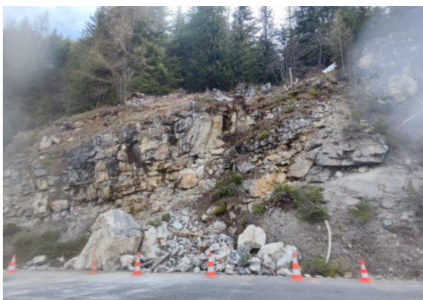
RD902 au PR39+680 à Tignes - éboulement
