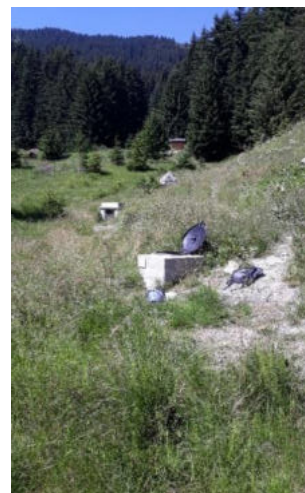
Visite du captage des Grandes Mouilles à Montagny (1525 m).
