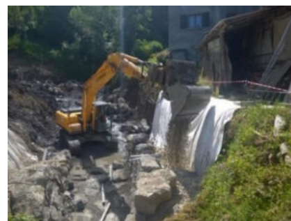
Travaux de réparation suite à une crue
