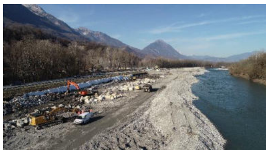
Chantier de sécurisation des digues de l'Isère à Montailleur
