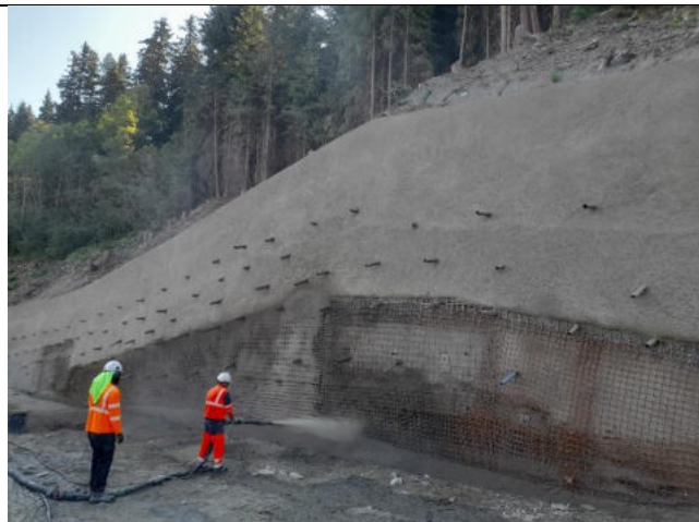
RD120 – Paroi clouée au droit du glissement de la Bottière
