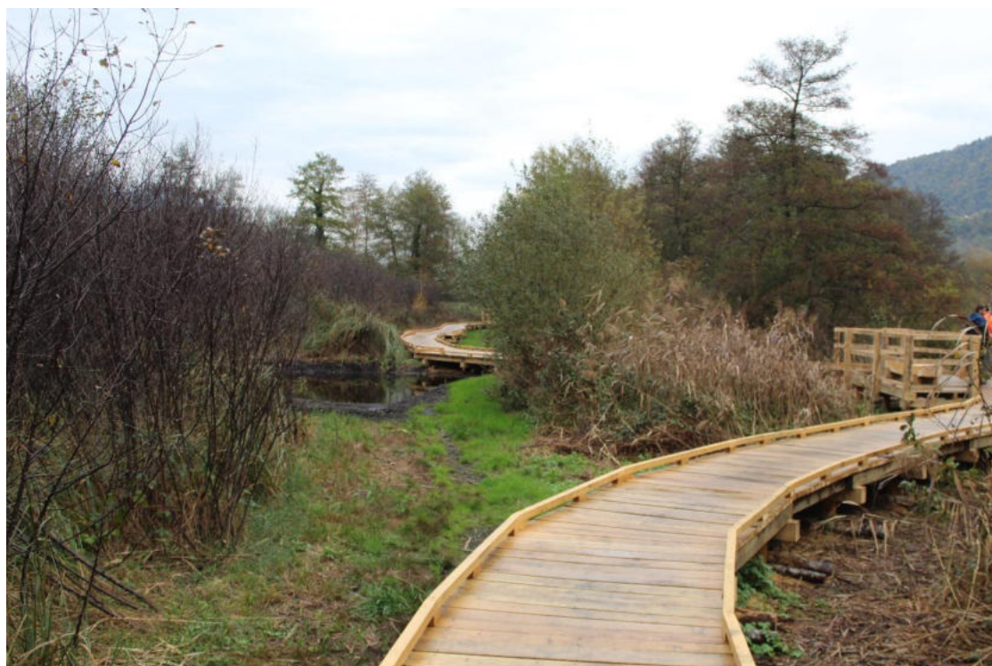
Appel à projets 2021 – réalisation 2022 : Travaux d'aménagement autour du lac de Sainte-Hélène – MOA Communauté de communes Cœur de Savoie © CD73
