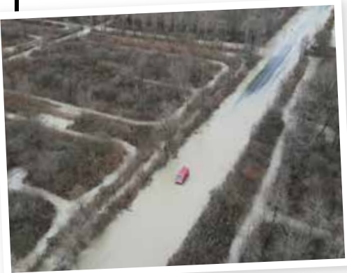
Chaussée inondée entre Vions et Chindrieux (RD57)
