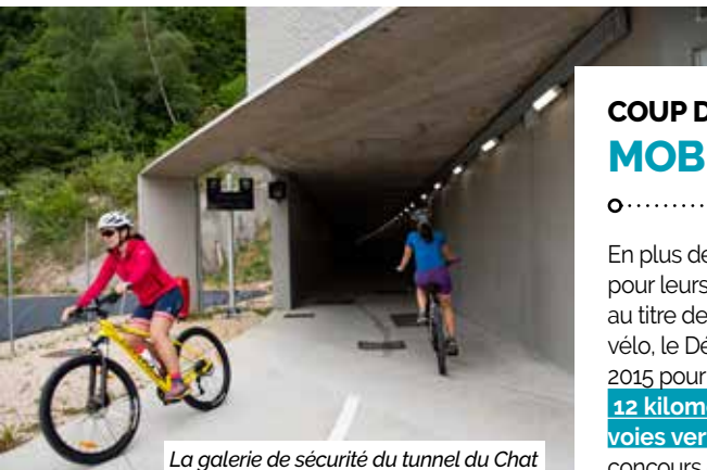
La galerie de sécurité du tunnel du Chat
