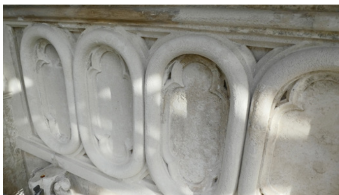
Remplages situés en partie supérieure de la façade ouest, en cours de restauration.
