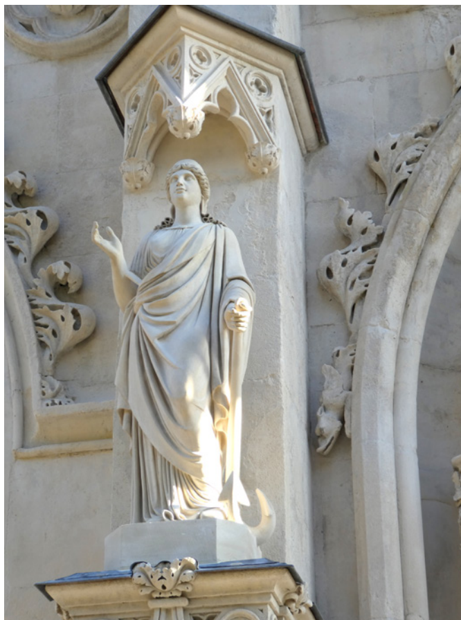
Statue de l'Espérance, protections au plomb formant larmier sur les dais et corniches.
