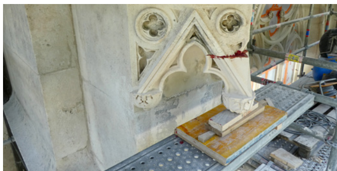
Grefe de pierre au niveau d'un dais. Restauration à l'Artopierre® des remplages supérieurs de la façade ouest.
