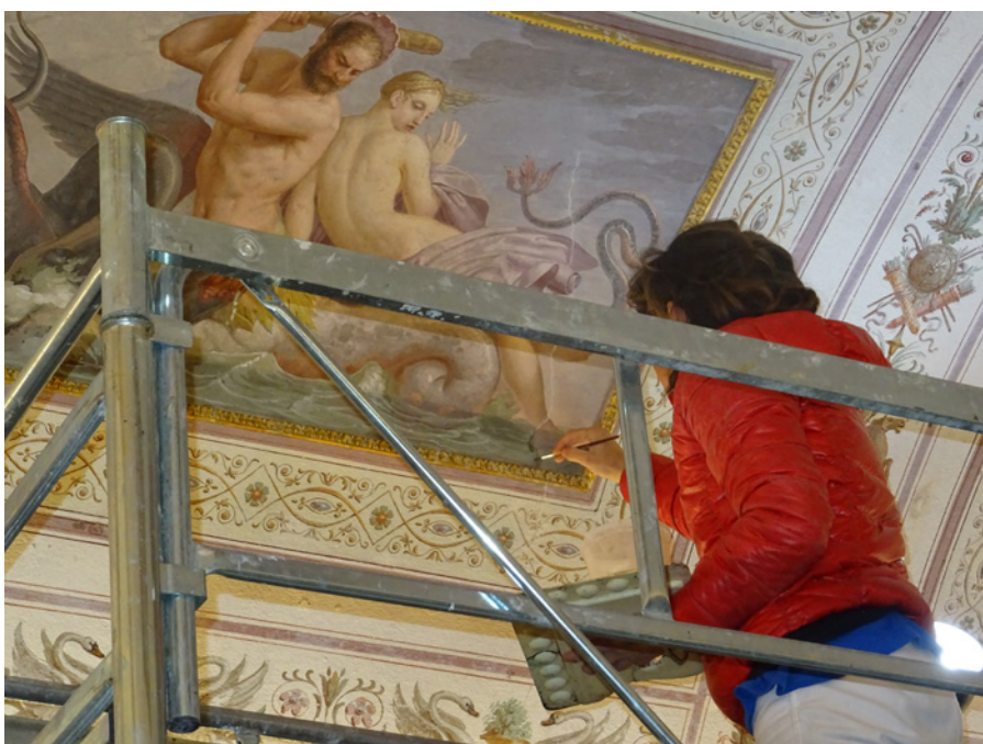
Bagni di Carlo Alberto, restauro.
