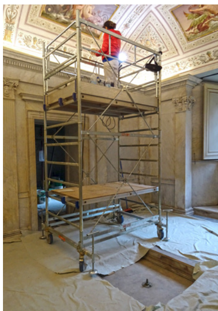
Bagni di Carlo Alberto, restauro.
