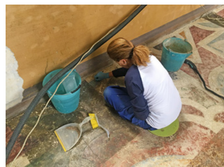
Il restauro della pavimentazione in stucco dipinto.
