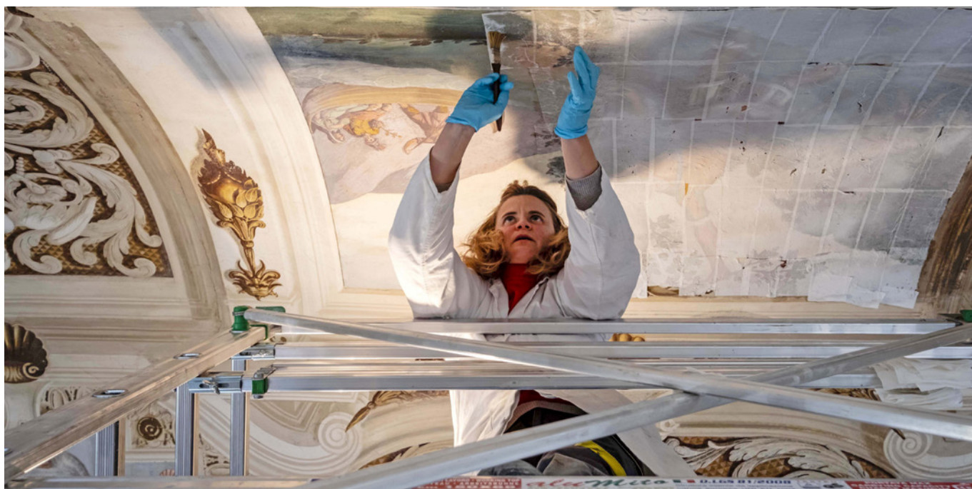
Una fase iniziale del restauro della volta con l'applicazione della carta giapponese.
